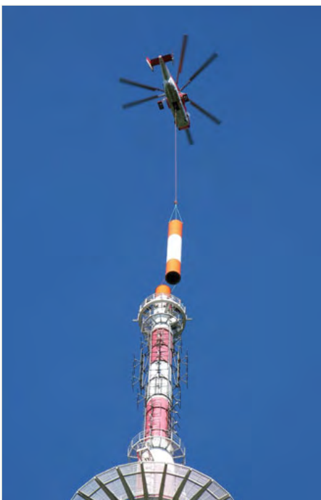
Aufbau eines Sendeturms für digitalen Rundfunk
